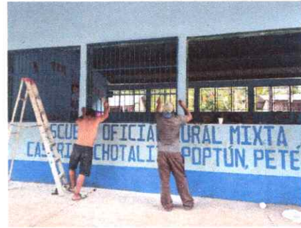
Foto 2: Instalación de balcones
