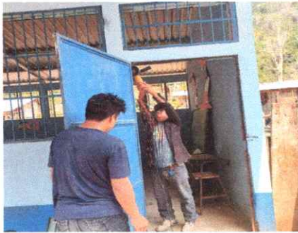
Foto 3: Instalación de puertas
