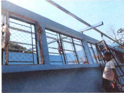
Foto1: Desmontaje de techo
