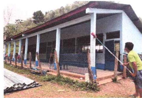
Foto 4: Pintando los módulos
