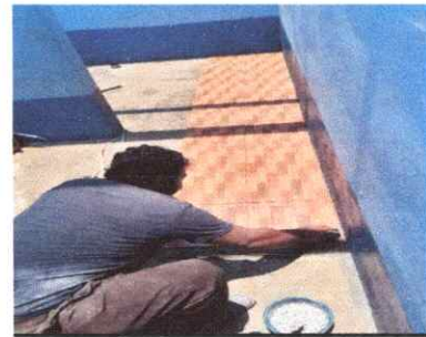
Foto 6: Colocación de piso cerámico
