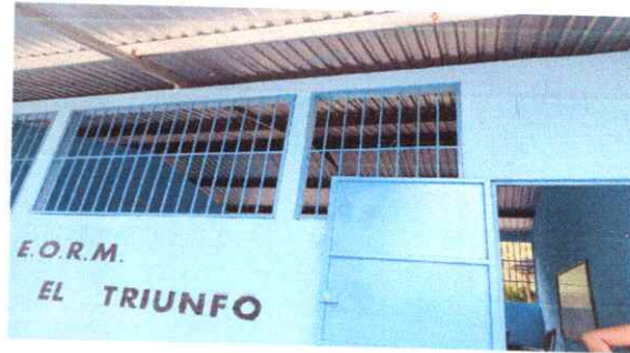
Foto 4: Pintura en muros interior y exterior
