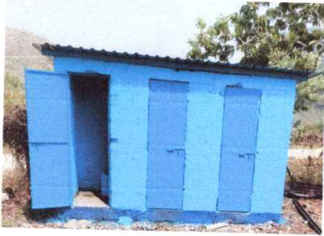
Foto 3: Techo, pintura y puertas terminadas
