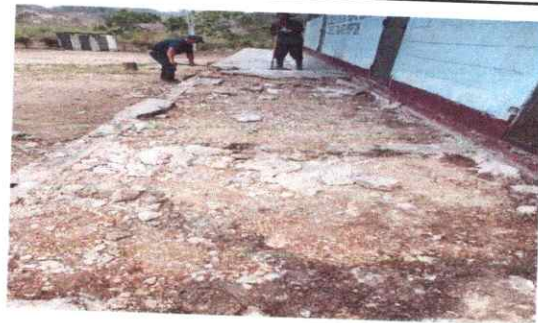
Foto 6: Reparación de banqueta
