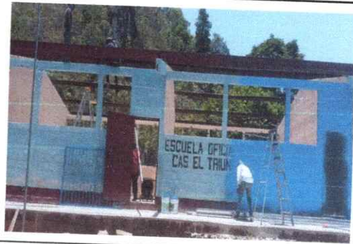
Foto 4: Avances Pintura en muros interior y exterior
