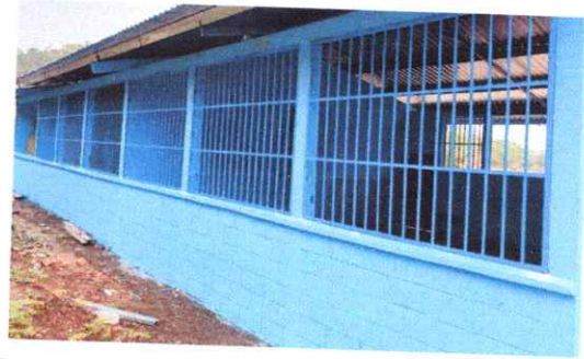
Foto 2: Instalación de ventanas
