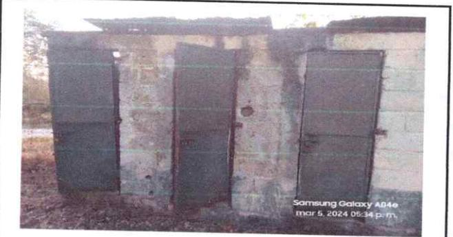
Foto 3: Techo, pintura y puertas deterioradas
