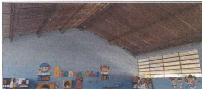
foto 2: Sustitución de estructura de techo ✓
