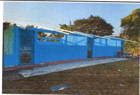
Foto 4: pintura de paredes
