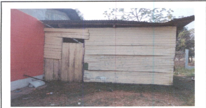
Foto 1: El antes de la bodega
