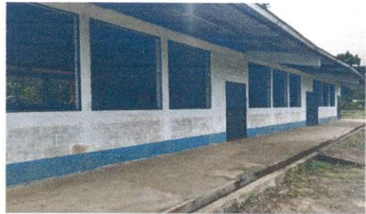
Foto 4: Pintura en muros exteriores e interiores
