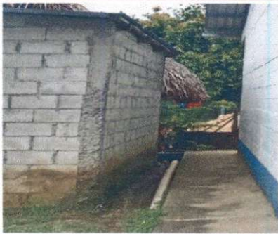
Foto 3: Repello en muro
