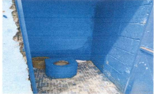
Foto 2: Sustitución de inodoro - Instalación de inodoro
