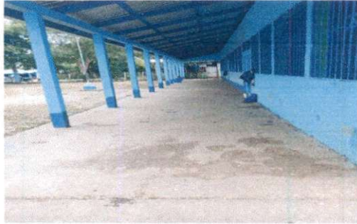
Foto1: Reparación de piso de torta de concreto por piso ceramico
