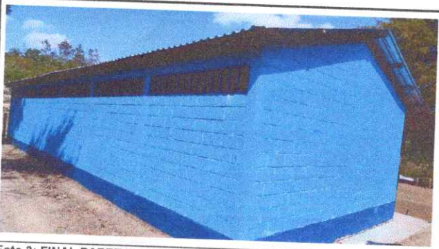
Foto 3: FINAL PARTE TRACERA SEGUNDO BLOQUE.
