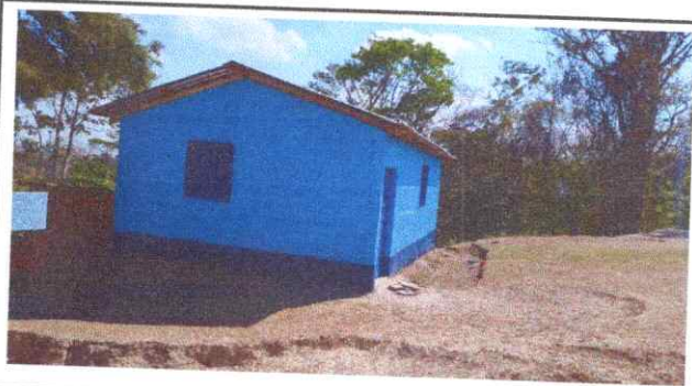
Foto 6: FINALIZACION TERCER BLOQUE.
