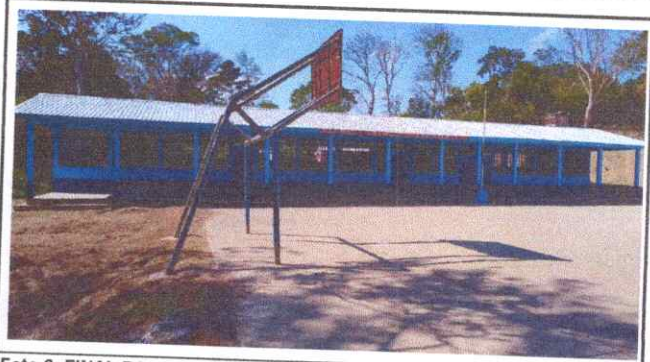
Foto 2: FINAL PARTE FRONTAL PRIMER BLOQUE.
