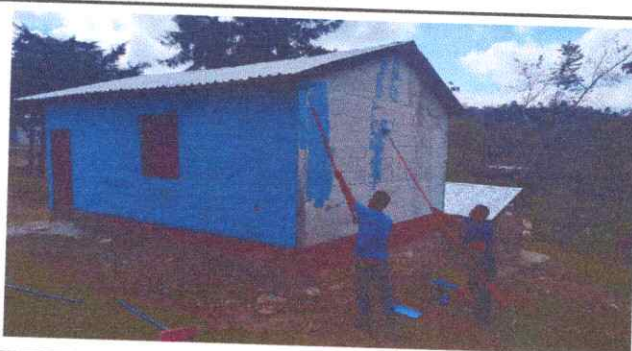
Foto 5: CAMBIO DE PINTURA TERCER BLOQUE.
