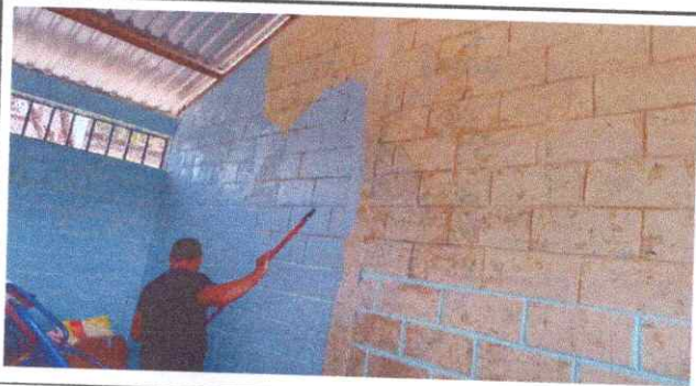
Foto 3: CAMBIO DE PINTURA AULAS SEGUNDO BLOQUE.
