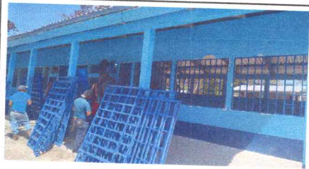
Foto 2: CAMBIO DE BALCONES PRIMER BLOQUE.
