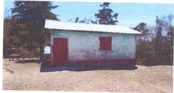
Foto 4: PUERTA, VENTANAS Y PINTURA PARTE FRONTAL TERCER BLOQUE.
