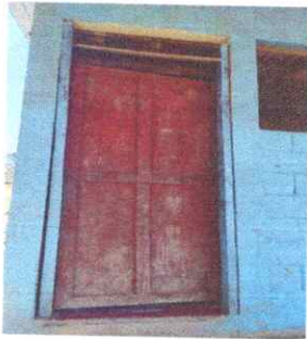
Foto 3: PUERTAS SEGUNDO BLOQUE PARTE FRONTAL.
