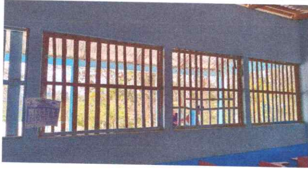
Foto1: BALCONES AULAS PRIMER BLOQUE.
