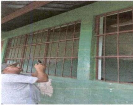
Foto 3: Sustitución de balcones de metal
