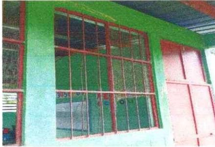
Foto 1: Sustitución de balcones-Fabricación e instalación de balcones de hierro en ventana
