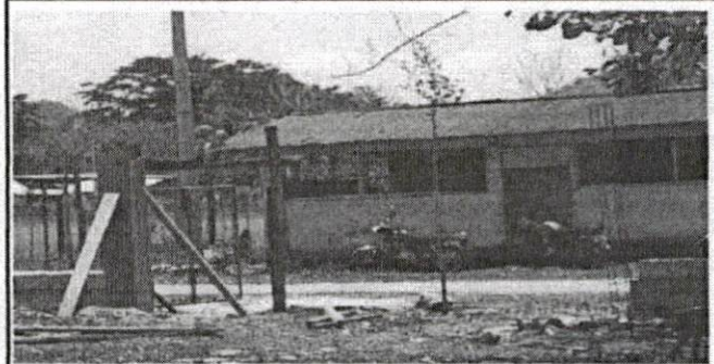
Foto 4: Colocacion de la primera base del porton de entrada principal
