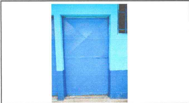
Foto 7: Sustrucción de chapas de puertas
