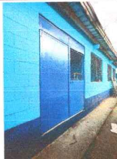
Foto 2: Fabricación e instalación de puertas en metal en módulos
