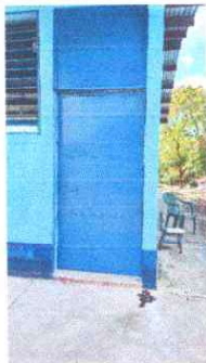
Foto 3: Fabricación e instalación de puertas en metal en módulos
