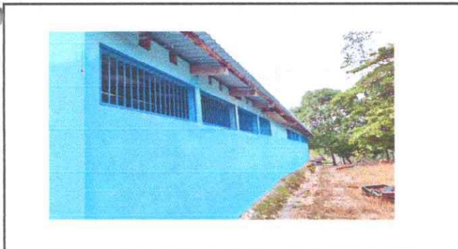
Foto 9: Fabricación e instalación de balcones de hierro en ventana
