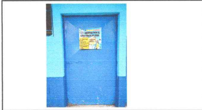
Foto 8: Sustrucción de chapas de puertas
