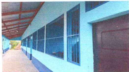
Foto1: Fabricación e instalación de balcones de hierro en ventana
