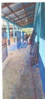
Foto1: Fabricación e instalación de balcones de hierro en ventana
