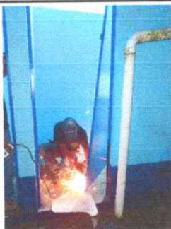
Foto 5: Fabricación e instalación de puertas en metal en baños
