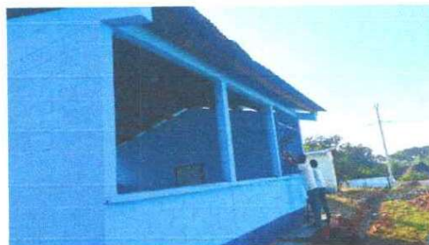
Foto 4: Fabricación e instalación de balcones de hierro en ventanas
