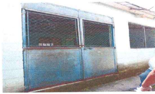
Foto 2: Fabricación e instalación de puertas en metal en módulos
