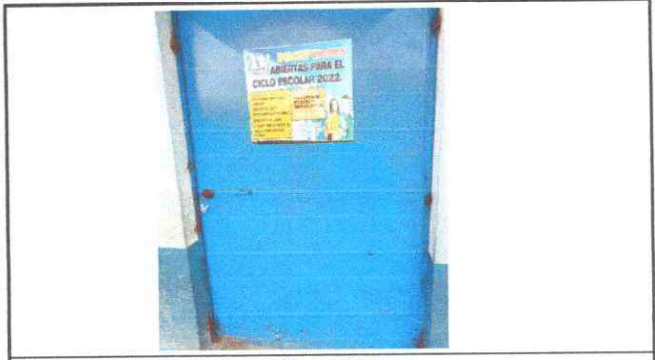
Foto 8: Sustrucción de chapas de puertas
