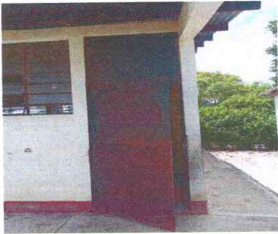
Foto 3: Fabricación e instalación de puertas en metal en módulos
