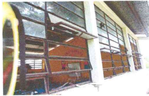
Foto 4: Fabricación e instalación de balcones de hierro en ventana
