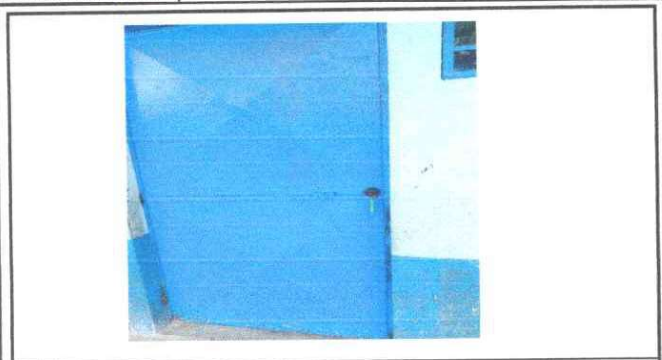
Foto 7: Sustrucción de chapas de puertas
