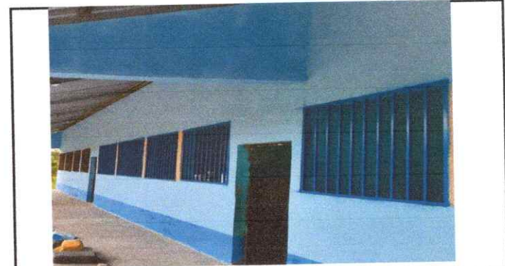
Foto 4: Pintura en muros exteriores e interiores
