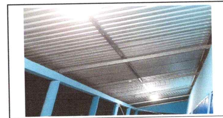
Foto 6: Sustitucion de focos ahorradores
