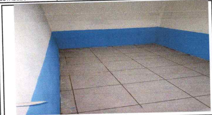
Foto1: Sustitucion de piso ceramico antideslizante en aulas
