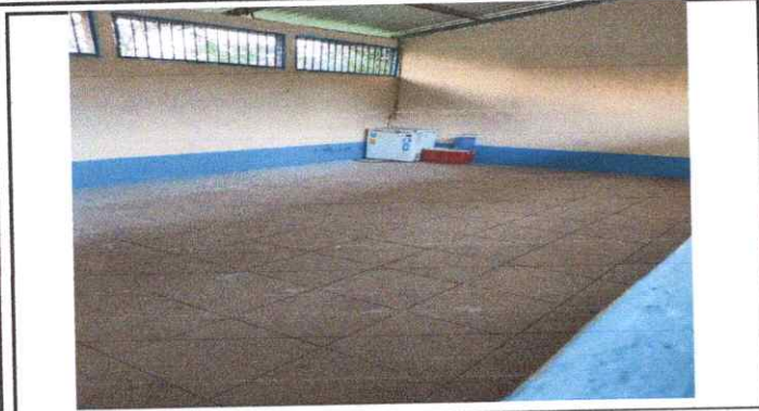
Foto1: Sustitucion de piso de torta de concreto
