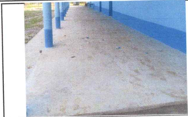
Foto 2: Reparacion de banquetas de Concreto
