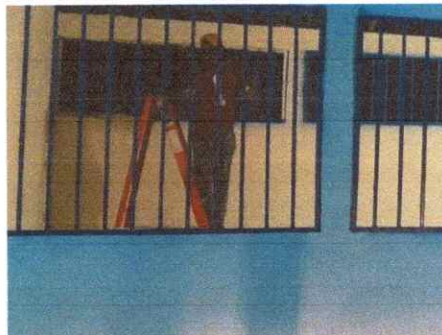
Foto 6: Sustitucion de focos ahorradores
