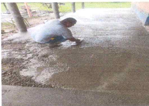
Foto 2: Reparacion de banquetas de Concreto
