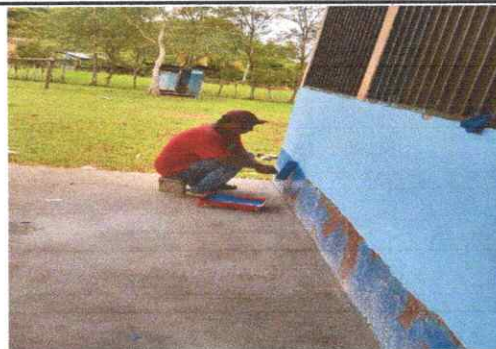
Foto 4: Pintura en muros exteriores e interiores
