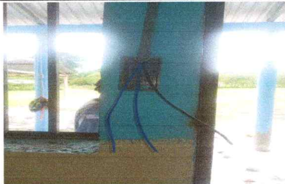
Foto 5: Reparacion de cableado electrico
