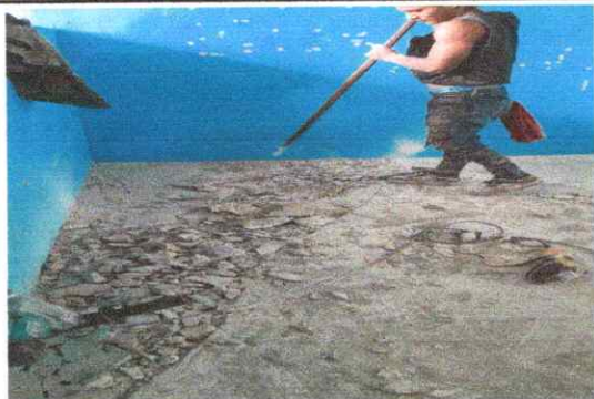
Foto1: Sustitucion de piso de torta de concreto
