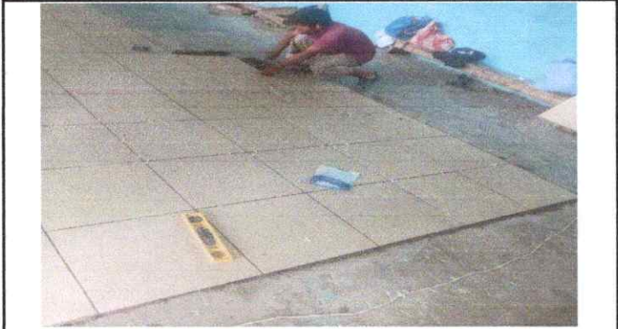
Foto1: Sustitucion de piso ceramico antideslizante en aulas
