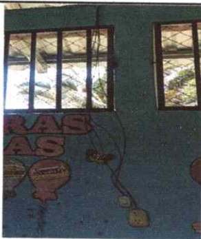
Foto 5: Reparación de cableado eléctrico
