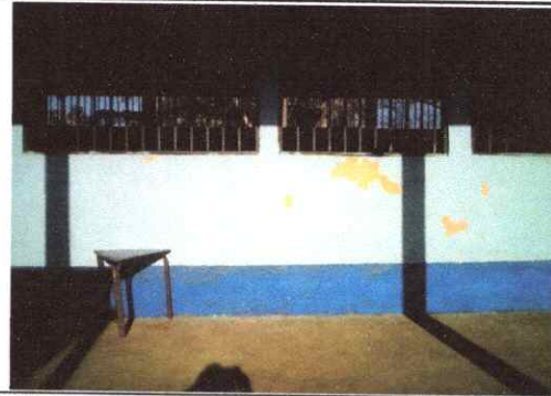
Foto 4: Pintura en muros exteriores e interiores
