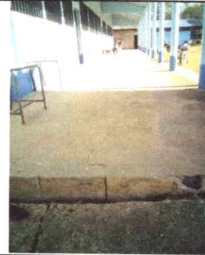
Foto 2: Reparación de banquetas de concreto
