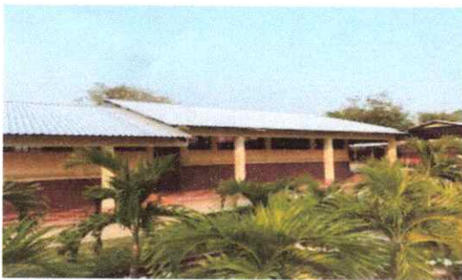
Foto 3: CAMBIO DE CUBIERTA DE LÁMINA AULA 3 Y 4
