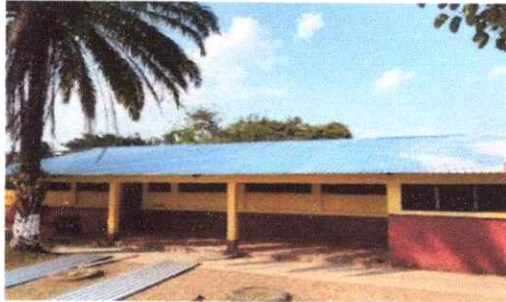
Foto1: CAMBIO DE CUBIERTA DE LÁMINA AULA 1
