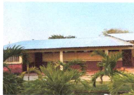
Foto 4: PARTE ENFRETE DE AULA 3 CAMBIO DE CUBIERTA DE LÁMINA
