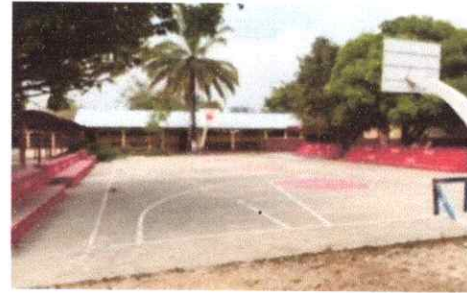
Foto 2: AULA 1 Y 2 CON CAMBIO DE CUEBIERTA DE LÁMINA
