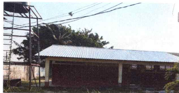
Foto 6: CAMBIO DE CUBIERTA DE LÁMINA ÁREA DE SANITARIO Y BODEGA Y PARTE DE SEGUNDO A
