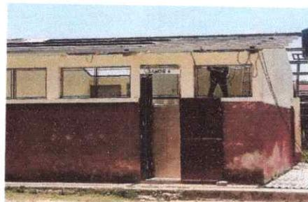
Foto 6: CAMBIO DE CUBIERTA DE LÁMINA ÁREA DE SANITARIO Y BODEGA.
