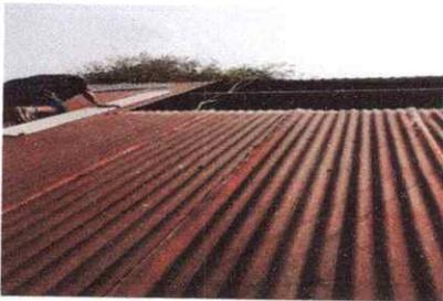
Foto 3: CAMBIO DE CUBIERTA DE LÁMINA AULA 3
