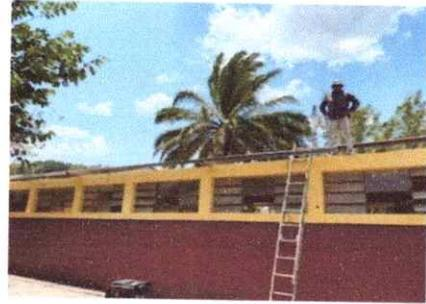
Foto 2: CAMBIO DE CUBIERTA DE LÁMINA AULA 1 Y 2 PARTE DE ATRÁS
