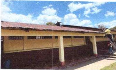
Foto1: CAMBIO DE CUBIERTA DE LÁMINA AULA 1
