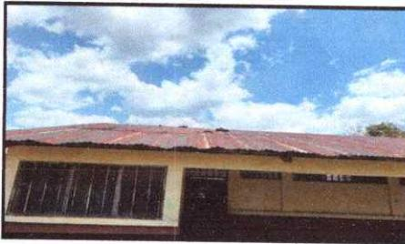
Foto 3: CAMBIO DE CUBIERTA DE LÁMINA AULA 3
