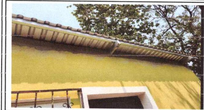
Estructura de techo y cubierna de lamina nueva
