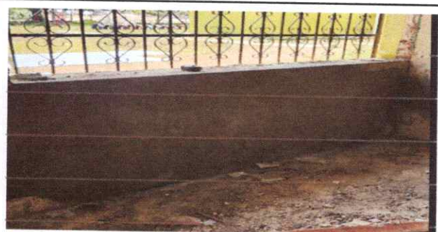
RESANAMIENTO DE PAREDES
