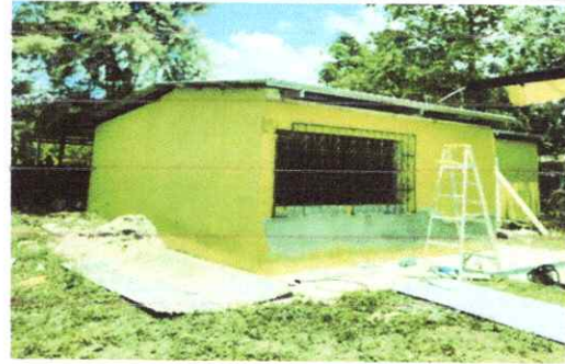
Reparación y cernido de paredes
