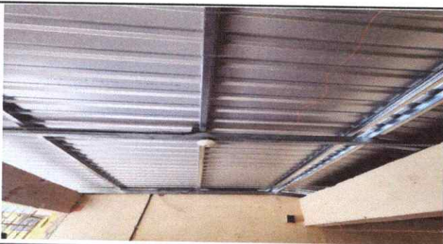
TECHO Y ESTRUCTURA NUEVA
