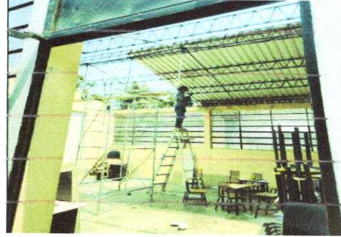
Colocación de lámina
