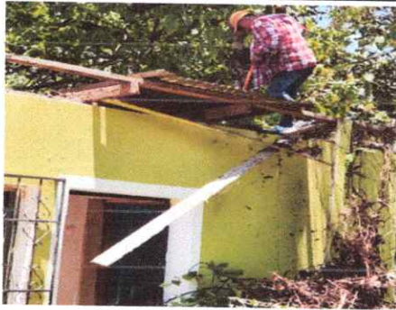
DESMANTELADO DE TECHO
