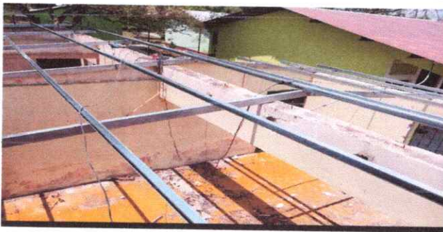
CAMBIO DE ESTRUCTURA DE TECHO
