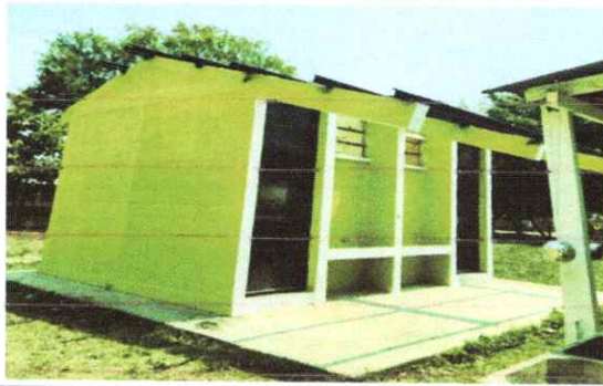
Cambio de estructura de techo y lámina de baños
