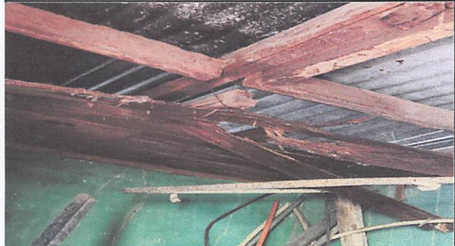
Lamins y estructura de techo bodega
