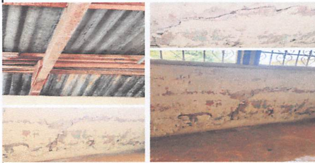
Estructura deTecho y pardes de dirección
