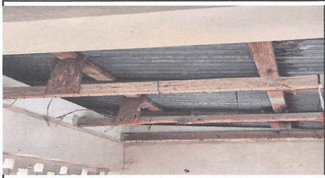
Estructura de techo
