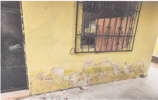
Paredes y ventanas
