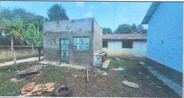
Foto 5: Techo de cocina
