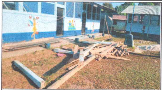
Foto 2: Techo de aulas
