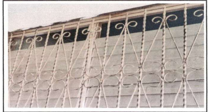
Foto 4: Sustitución de vidrios, mantenimiento a estructura de metal ventana, pintura en muros exteriores e interiores. ✓
