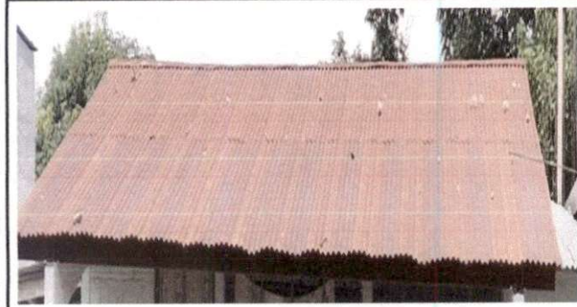
Foto 1: Aluzinc calibre 26, sustitución de capote de lámina para lámina troquelada ✓
