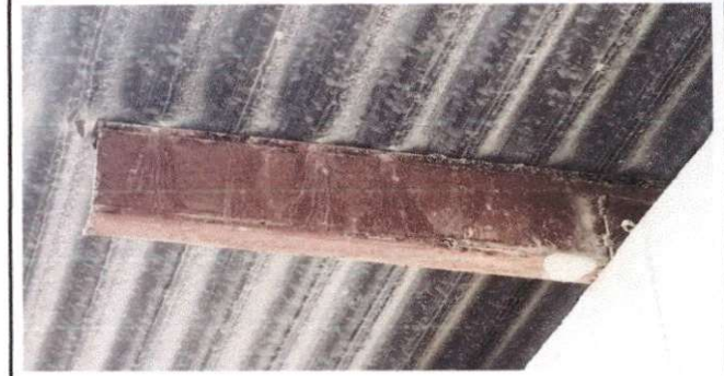
Foto 2: Mantenimiento a estructura de soporte de metal, instalación de unidades de luz (incluye ducto y cable eléctrico), instalación de unidades de fuerza (tomacorriente). ✓
