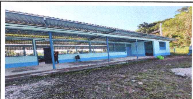
Foto 5: Pintura en muros exteriores e interiores
