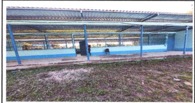
Foto 2: Sustitución de elementos de fijación
