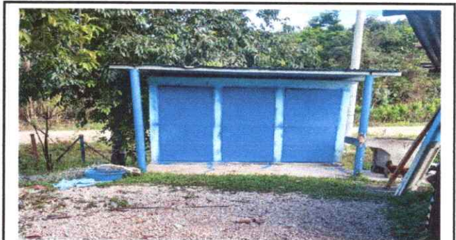
Foto 4: Sustitución de puertas en servicios sanitarios
