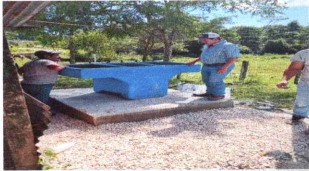
Foto1: Instalación de pila
