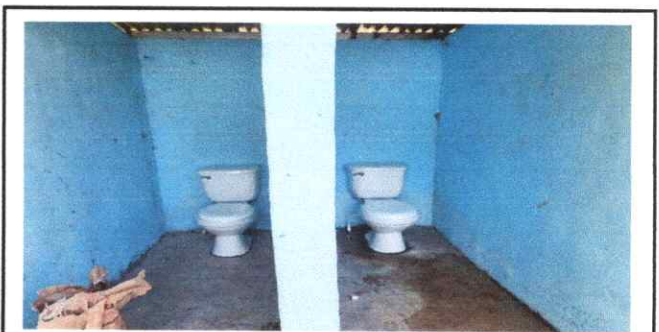
Foto 6: Sustitucion de inodoro
