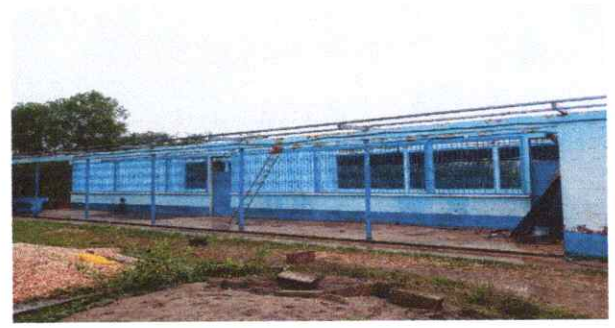
Foto 2: Sustitución de elementos de fijación
