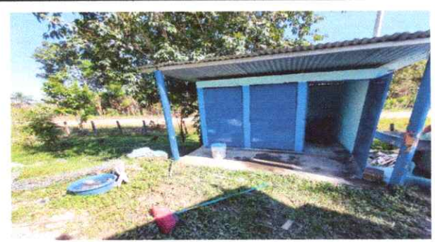
Foto 4: Sustitución de puertas en servicios sanitarios
