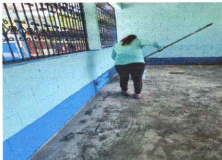
Foto 5: Pintura en muros exteriores e interiores
