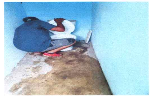
Foto 6: Sustitucion de inodoro
