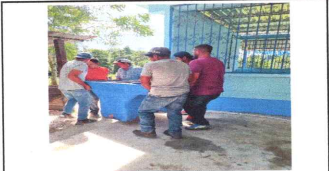
Foto1: Instalación de pila
