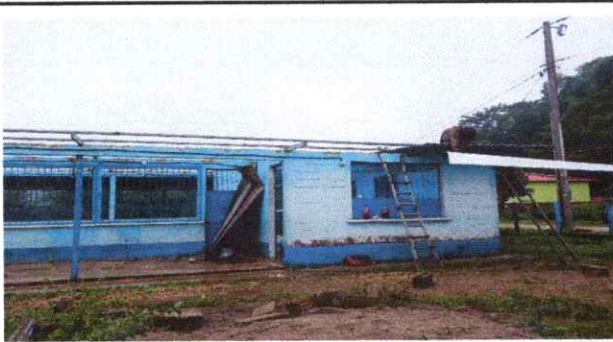
Foto 3: sustitución de estructura de elemento de soporte de metal por metal
