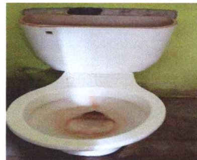
Foto 6: Sustitución de inodoro
