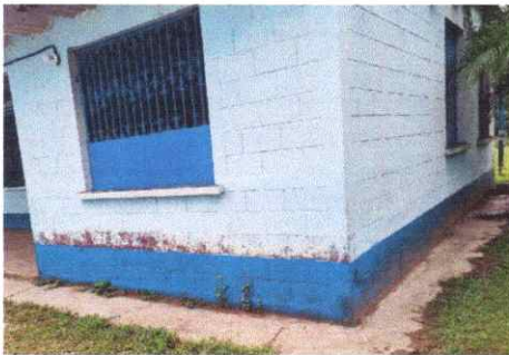
Foto 5: Pintura en muros exteriores e interiores
