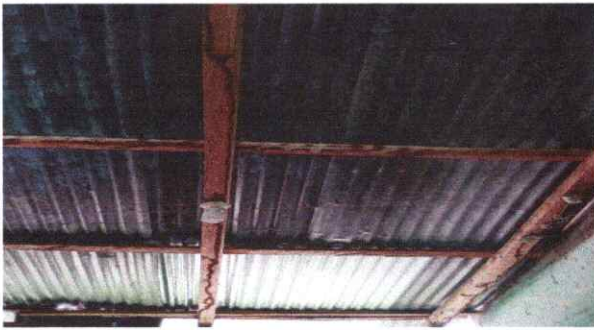
Foto 3: sustitución de estructura de elemento de soporte de madera, por metal
