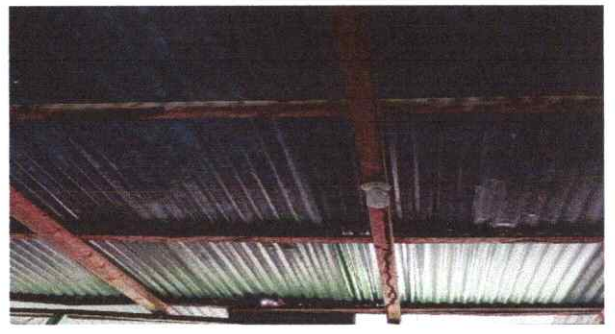
Foto 2: Sustitución de elementos de fijación
