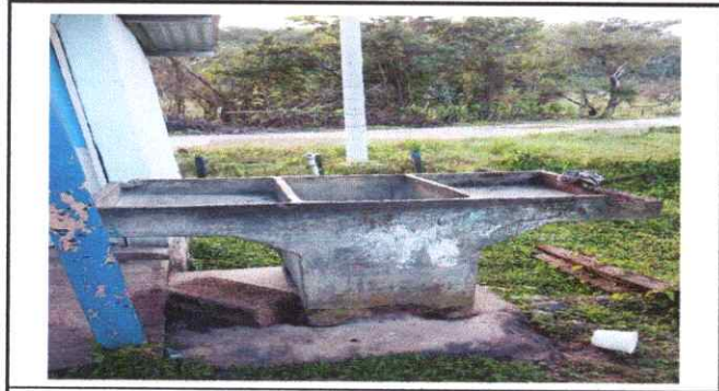
Foto 1: Instalación de pila
