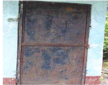
Foto 4: Sustitución de puertas en servicios sanitarios
