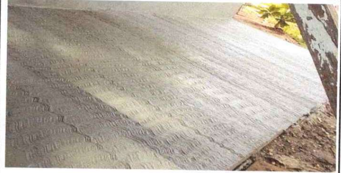
SUSTITUCIÓN DE TORTA DE CONCRETO
