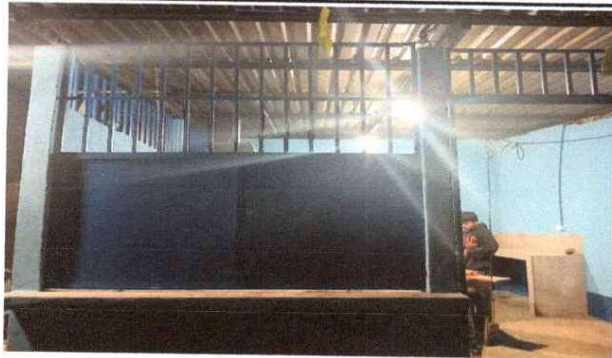
SUSTITUCION DE BALCON DE METAL EN VENTANA
