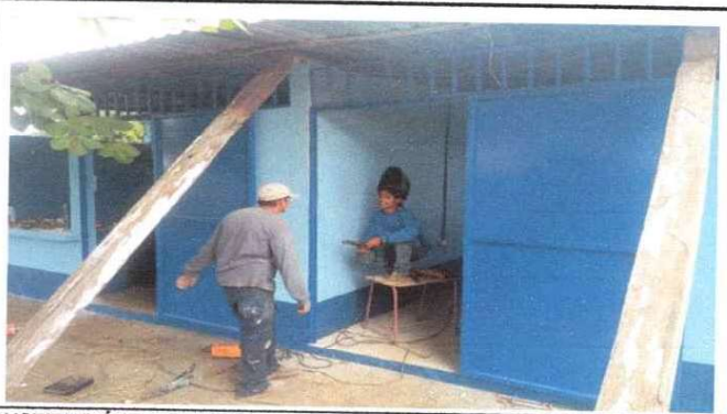
SUSTITUCIÓN DE PUERTAS EN MODULO DE COCINA
