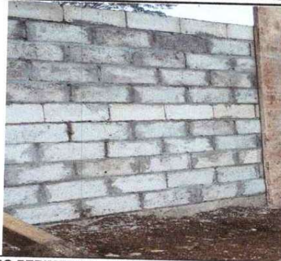
REPARACION DE MURO PERIMETRAL DE BLOCK
