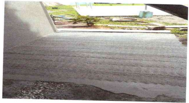
SUSTITUCIÓN DE TORTA DE CONCRETO
