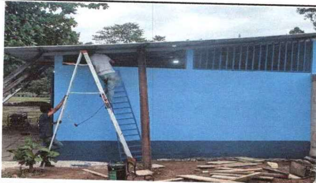
SUSTITUCION DE BALCON DE METAL EN VENTANA
