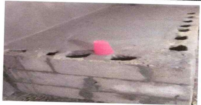
INSTALACION DE AZULEJO EN COCINA RURAL
