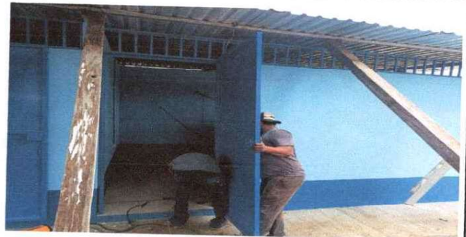
SUSTITUCIÓN DE PUERTAS EN MODULO DE COCINA
