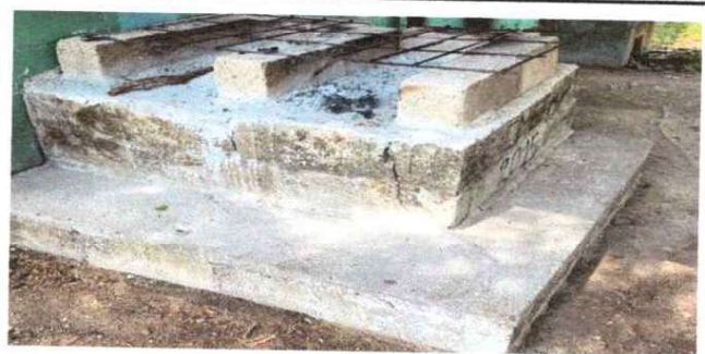
INSTALACION DE AZULEJO EN COCINA RURAL
