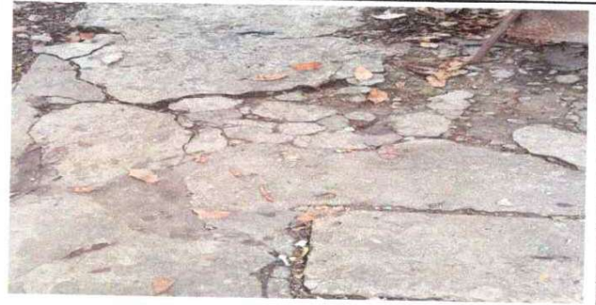
SUSTITUCIÓN DE TORTA DE CONCRETO
