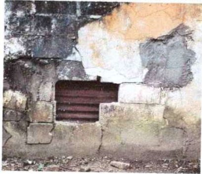
REPARACION DE MURO PERIMETRAL DE BLOCK
