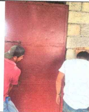
SUSTITUCIÓN DE PUERTAS EN MODULO DE COCINA
