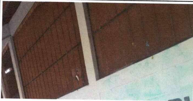
SUSTITUCION DE BALCON DE METAL EN VENTANA
