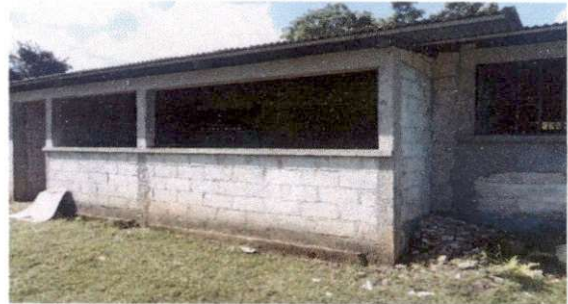
Foto 6: Pintura en muros exteriores e interiores
