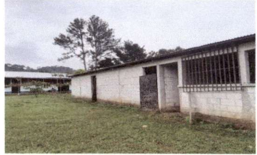
Foto 2: Sustrucción de estructura de metal en ventana-Fabricación e instalación
