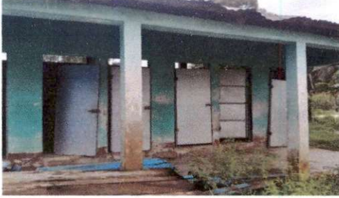
Foto 1: Sustrucción de puertas en servicio sanitario-Fabricación e instalación
