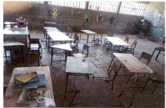
Foto 4: Reparación de piso de torta de concreto
