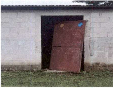
Foto 3: Sustrucción de puertas- Fabricación e instalación
