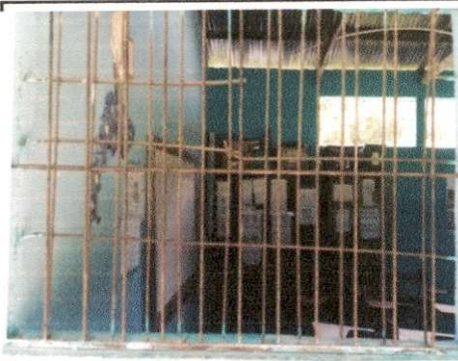
Foto 6: RESTAURACION Y MANTENIMIENTO DE BALCONES DEL AULA DE SEXTO
