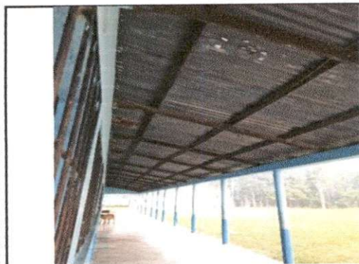
Foto 3: LAMINA DEL CORREDOR DE LAS AULAS A INTERVENIR
