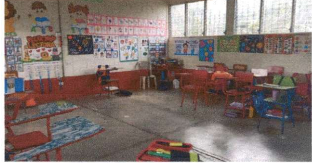
Foto 2: Reparacion de piso de cemento liquido
