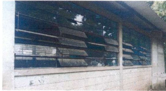
Foto 4: Mantenimiento a estructura de metal de ventana
