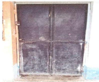
Foto 6: Mantenimiento a estructura(lijado, cambio de tubo, cepillado, sujecciones y aplicación de pintura.
