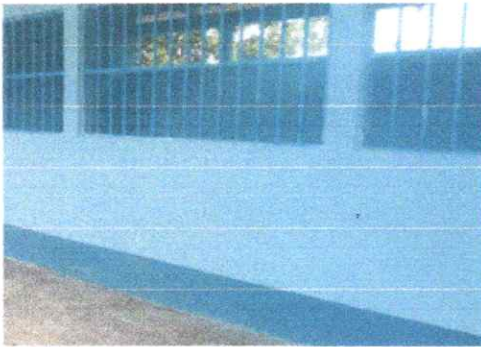
Foto 3: Pintura en muro interior y exterior
