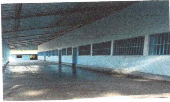
Foto 1: Reparación de piso de cemento líquido.
