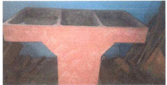
Foto 4: Sustitución de pila de cemento de dos lavaderos
