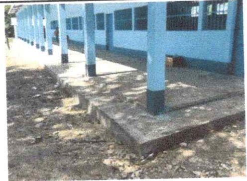
Foto 2: Reparación de banqueta de concreto
