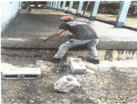
Foto 1: Reparación de piso de cemento líquido.
