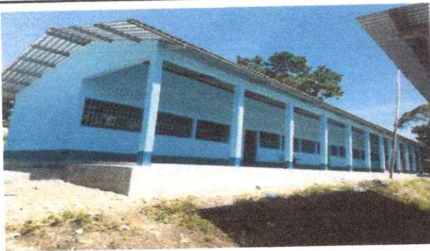
Foto 3: Pintura en muro interior y exterior
