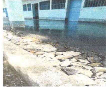
Foto 2: Reparación de banqueta de concreto
