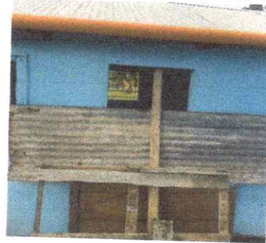
Foto 2: Fabricación e instalación de puerta de metal en cocina
