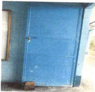
Foto 3: Mantenimiento de puertas para aulas, dirección y bodega
