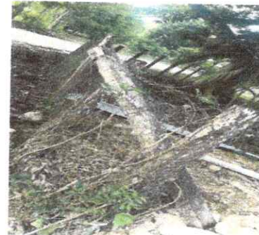
Foto 4: Sustitución de cerco de malla y alambre de pua
