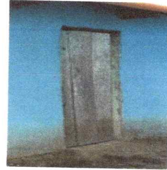
Foto: Fabricación e instalación de puerta de metal en cocina
