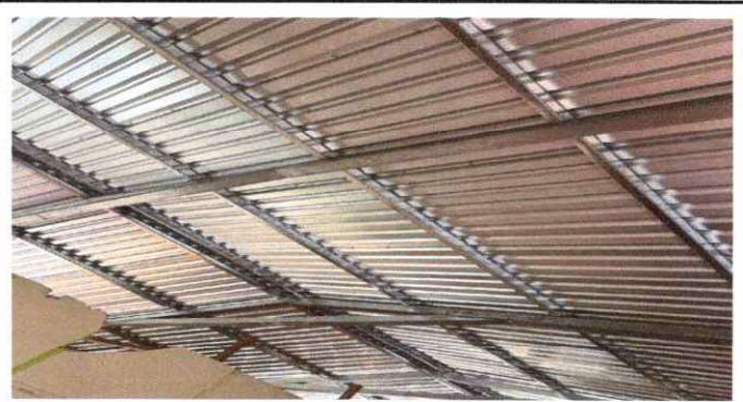
FOTO 4: SUSTITUCION DE ESTRUCTURA
