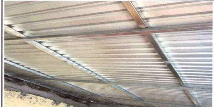
FOTO 6: SUSTITUCION DE ESTRUCTURA
