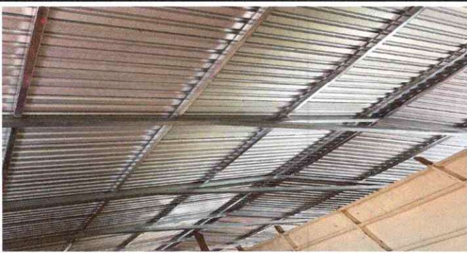
FOTO 3: SUSTITUCION DE ESTRUCTURA
