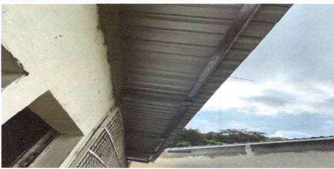
FOTO 5: SUSTITUCION DE LAMINA
