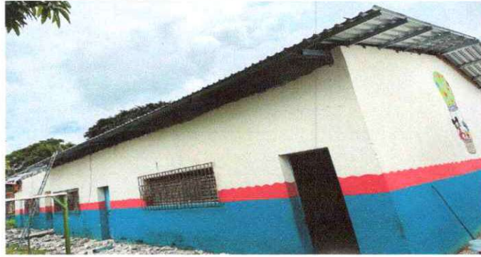
FOTO 1: CAMBIO DE LAMINA POR LAMINA DE ALUZIN.
