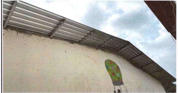
FOTO 2: CAMBIO DE LAMINA POR LAMINA DE ALUZIN.
