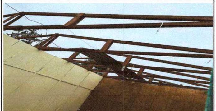
FOTO 2: CAMBIO DE LAMINA POR LAMINA DE ALUZIN.
