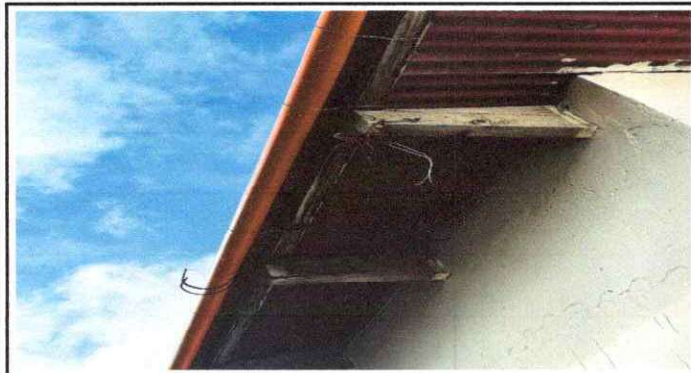
FOTO 1: CAMBIO DE LAMINA POR LAMINA DE ALUZIN.
