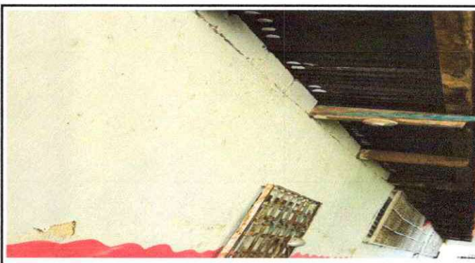
FOTO 4: SUSTITUCION DE ESTRUCTURA
