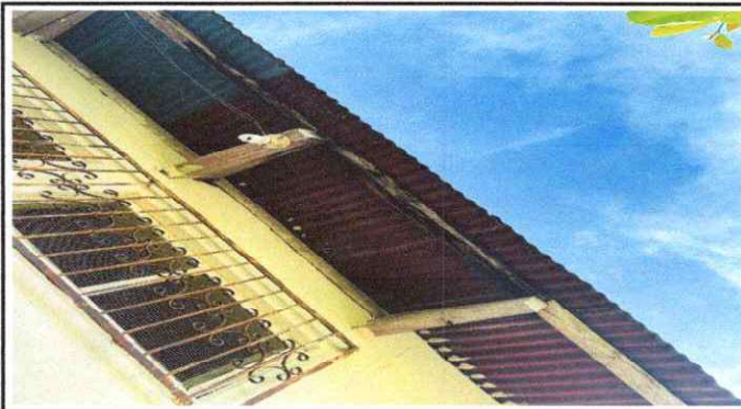
FOTO 2: CAMBIO DE LAMINA POR LAMINA DE ALUZIN.
