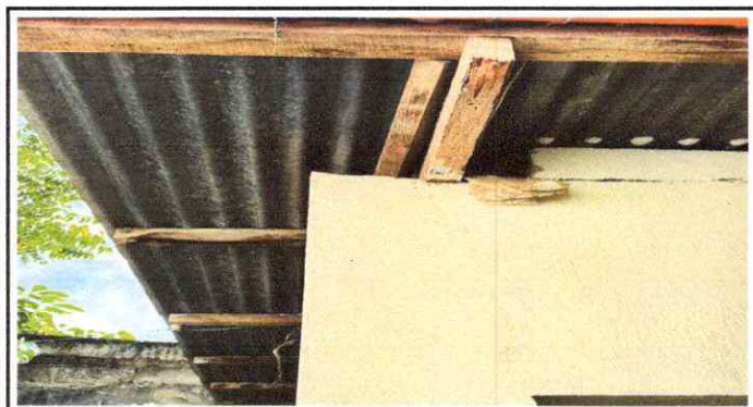
FOTO 3: SUSTITUCION DE ESTRUCTURA
