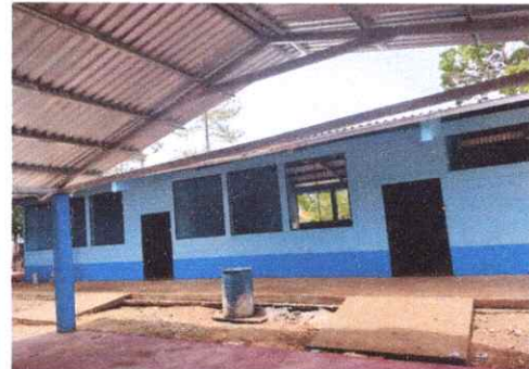
Foto 2: PINTURA PARA INTERIOR Y EXTERIOR DE AULAS
