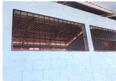
Foto 4: COLOCACIÓN DE BALCONES
