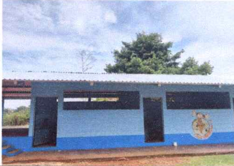
Foto1: CAMBIO DE TECHO Y LÁMINA
