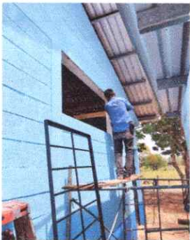
Foto 3: COLOCACIÓN DE BALCONES PARA BODEGA
