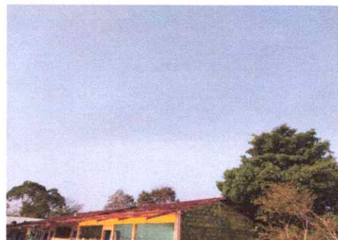
Foto 4: CAMBIO DE ESTRUCTURA Y LÁMINAS
