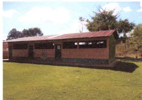
Foto 4: PINTURA PARA PAREDES Y BALCONES
