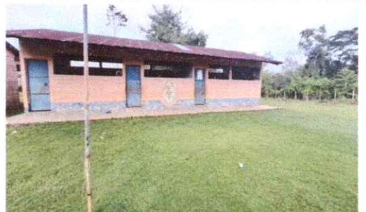
Foto 5: CAMBIO DE PUERTAS
