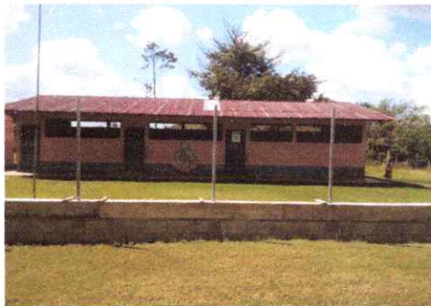
Foto 3: CAMBIO DE LÁMINAS Y COSTANERAS
