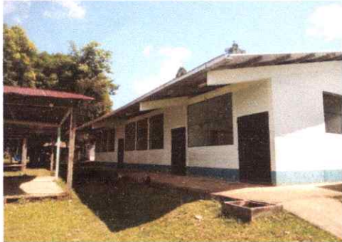
Foto 1: PINTURA PARA AULAS
