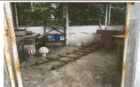
Foto 6: SUSTITUCION DE PISO DE TORTA
