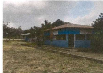
Foto 4: Pintura en muros en exteriores e interiores.
