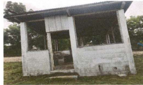
Foto 2: REPELLO EN MUROS
