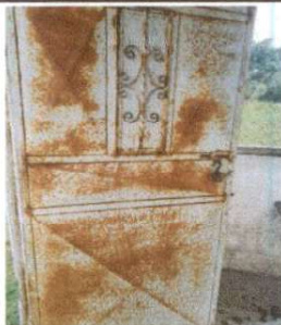
Foto 5: SUSTITUCION DE PUERTAS EN MODULOS
