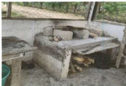
Foto 3: SUSTITUCION DE ESTUFA RURAL COMPLETA (INCLUYE CHIMENEA Y PLANCHA DE METAL)
