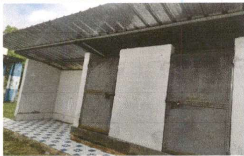
Foto 1: SUSTITUCION DE PUERTAS EN BAÑOS
