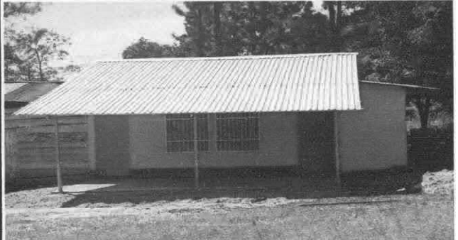
Foto 2: Instalación de lámina troquelada de corredor
