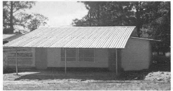
Foto 4: Pintura en muros exteriores e interiores
