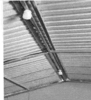
Foto 2: Sustitución de estructura de soporte de madera por metal.
