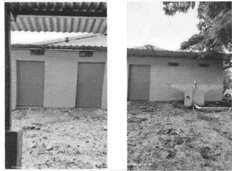
Foto 2: Instalación de puertas de metal en baños y bodega
