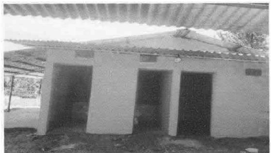
Foto 5: Reparación de muro perimetral de block de baños y bodega
