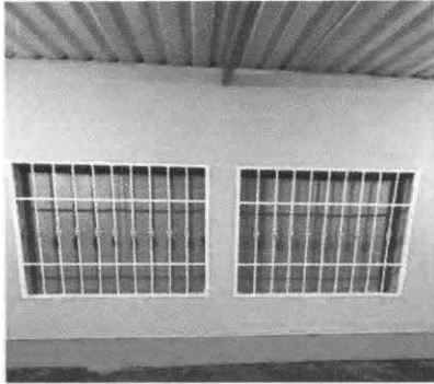
Foto1: Instalación de balcón de ventanas
