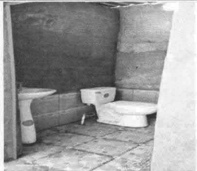
Foto 6: Sustitución de inodoro y lavamanos
