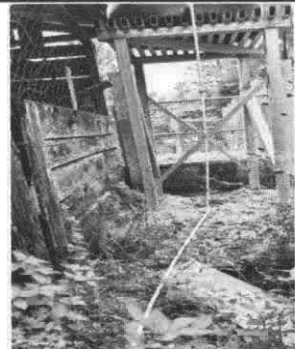
Foto 4: Sustitución de bajada de agua de rotoplas de tubo PVC
