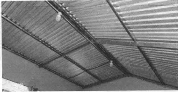
Foto 1: Sustitución de lamina por lamina troquelada
