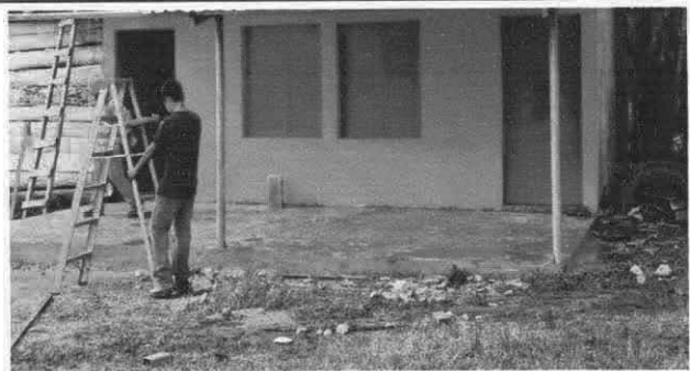
Foto1: Reparación de plancha de concreto de patio
