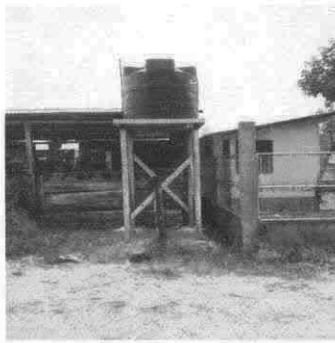
Foto 3: Sustitución de deposito de agua
