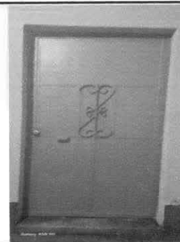
Foto 6: Sustitución de puerta de madera por metal
