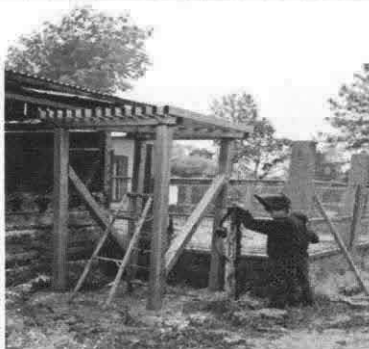
Foto 3: Sustitución de depósito de agua
