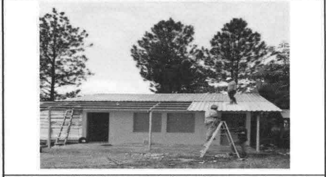
Foto 2: Instalación lámina troquelada de corredor
