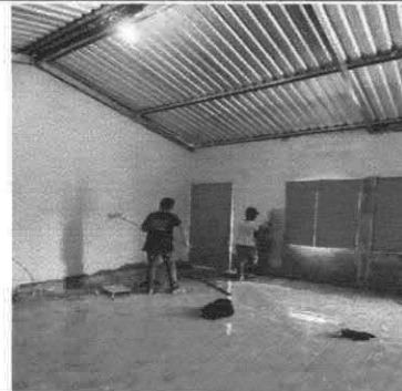
Foto 4: Pintura en muros exteriores e interiores
