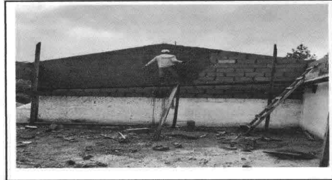
Foto 4: Levantamiento de muro perimetral
