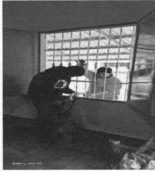
Foto1: Instalación de blacón de ventanas.
