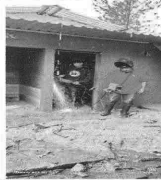
Foto 2: Instalación de puertas de metal en baños y bodega
