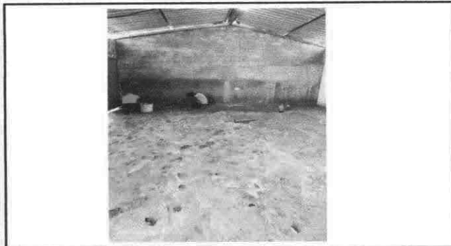
Foto 3: Sustitución de piso de torta de concreto
