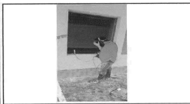
Foto 5: Sustitución de ventana de madera por metal
