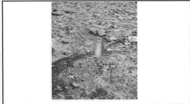
Foto 3: Sustitución de tubería de PVC línea principal de aguas negras.
