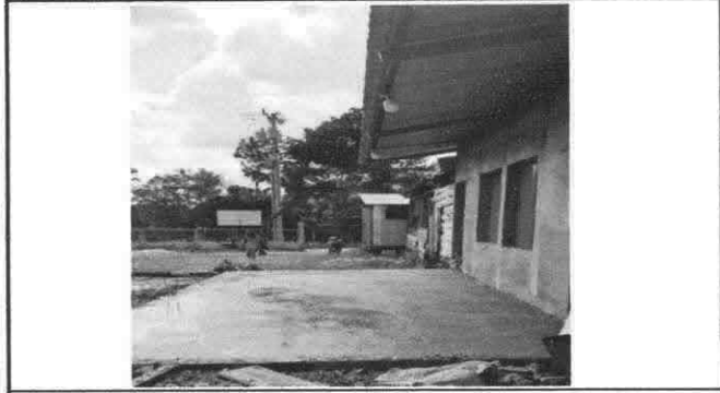
Foto1: Reparación de plancha de concreto de patio.
